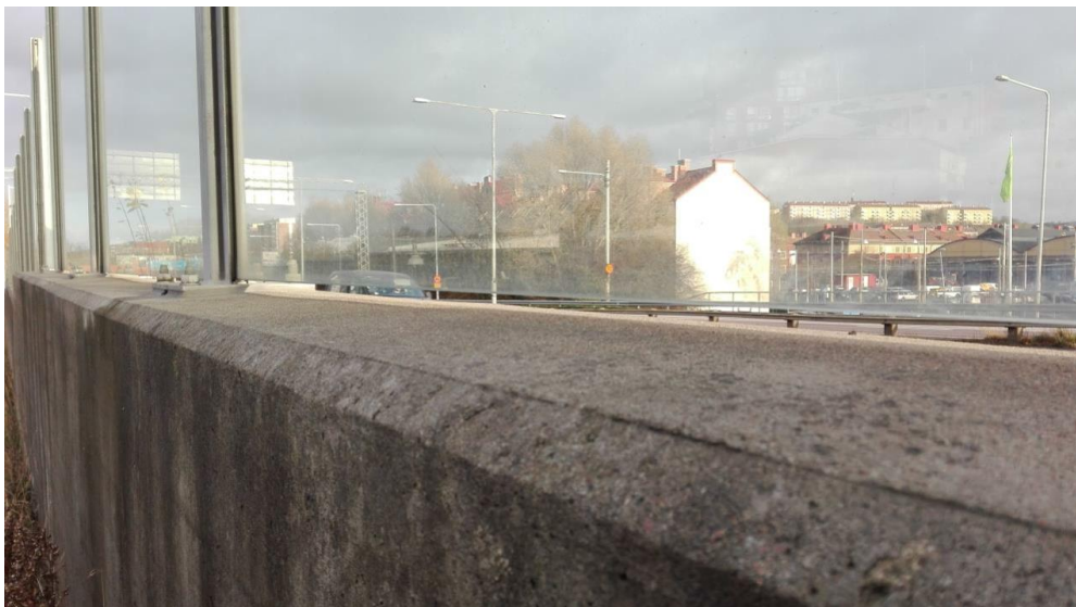
Figur 3 Bullerskyddsskärm längs Oscarsleden som består av betongfundament och glasparti med glipa mellan dessa.
